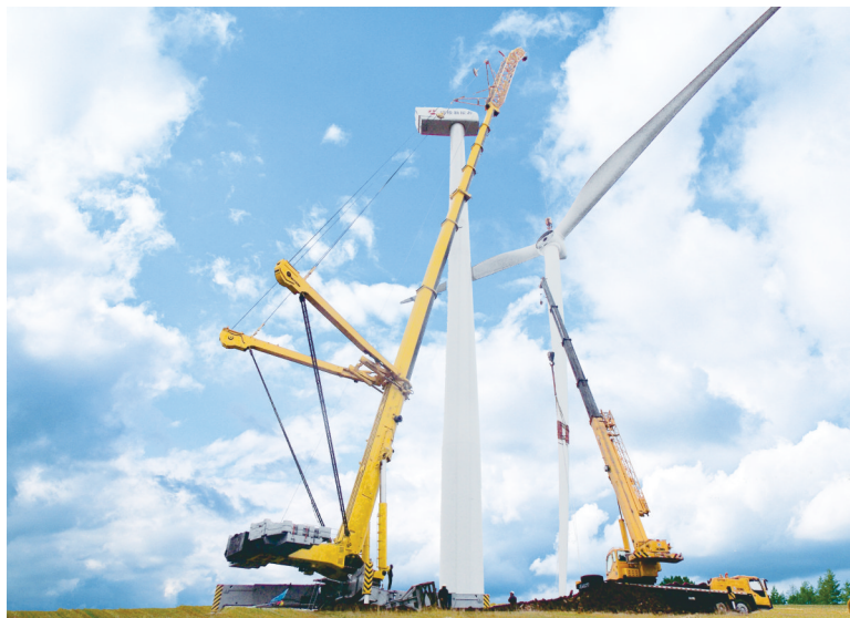
TZT1200履带式伸缩臂起重机吊装风电整机
